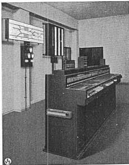
Bild 2. Halbselbsttätiges Stellwerk „Stu“, Stettiner Bahnhof
